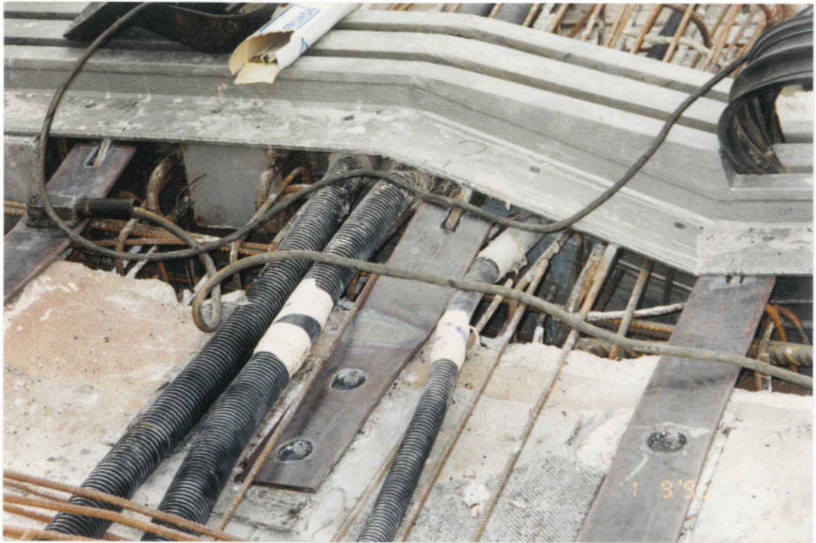
Bilddarstellung: LEERROHRE IN DEN KAPPEN 1. BA Wlg. HX
